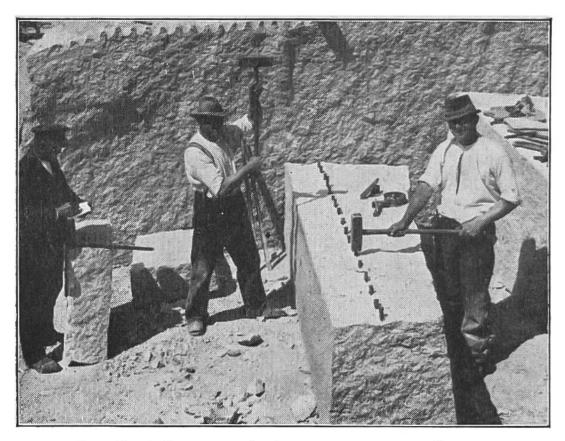
Der Steinblock wird erst gut gelagert, damit nicht ung ünstige Spannungen ein Spalten in unerwünschter Richtung bewirken; dann werden die Stahlkeile mit bemessenen Hammerschlägen gleichmässig immer tiefer eingetrieben.
