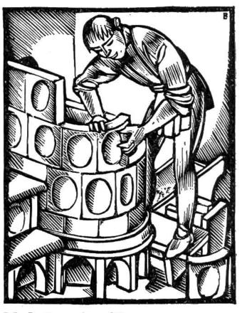
Ofenbauer vereint mittelst Lehm gebrannte und glasierte Tonkacheln zu einem Kachelofen. Die Öfen waren bis zum 8. Jahrh. nur Back-, Koch- u. Brennöfen und dienten erst später Heizzwecken. Aus diesen plumpen, gemauerten Ziegelöfen entwikkelte sich der Kachelofen. Seit Ende des Mittelalters entstehen immer formschönere Kachelöfen, deren Kacheln meist gefärbt und verziert sind. Wahre Prunkstücke entstanden in Schweizer Werkstätten. Winterthurer Öfen zum Beispiel waren weitum berühmt.
