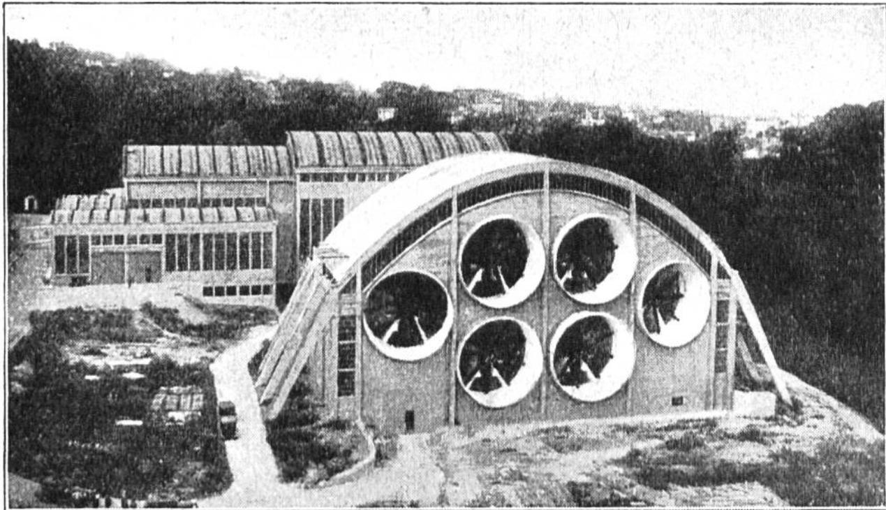
Riesenbauten zur Prüfung von Flugzeugen auf ihre Leistungen und ihre Widerstandsfähigkeit. Mit Hilfe der vorn sichtbaren sechs mächtigen Ventilatoren werden orkanartige Windströmungen erzeugt, denen die Flugzeuge standhalten müssen. Der Bau der neuartigen Anlage war sehr kostspielig, aber es werden dadurch viele schwere Unglücksfälle verhütet. Zum Ermessen der Grösse des gewaltigen Blaswerkes beachte die beiden Autos auf der Strasse.
