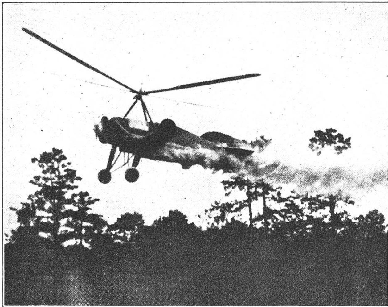
Windmühlenflugzeug bei der Insektenbekämpfung. Diese Apparate können fast senkrecht aufsteigen und landen. Nur wenige Meter hoch fliegen sie über den Pflanzungen dahin; über höhere Bäume können sie sich leicht erheben.
