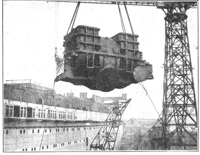
Riesenkräfte an der Arbeit. Der Kran hat ein 112000 kg schweres Turbinengehäuse in die Luft gehoben, und gleich wird er es mit einigen eleganten Bewegungen in den Maschinenraum des im Bau befindlichen mächtigen Dampfers versenken.
