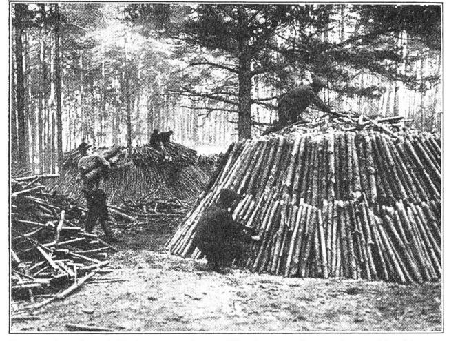
Das Aufschichten des Holzes für den Meiler. Um die Luftzufuhr während des Verbrennens auf ein Mindestmass herabzusetzen, werden die Meiler mit Erde bedeckt.
