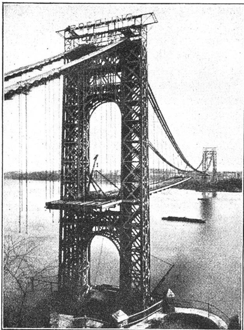
George Washington - Brücke über den Hudson bei New York während des Baues.
