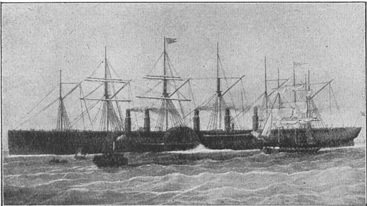
Ein interessantes Bild aus der Übergangszeit vom Segelschiff zum Dampfer. Dieses 1852 auf Stapel gelegte Schiff bediente sich sowohl der Wind- wie der Dampfkraft als Antriebsmittel.
