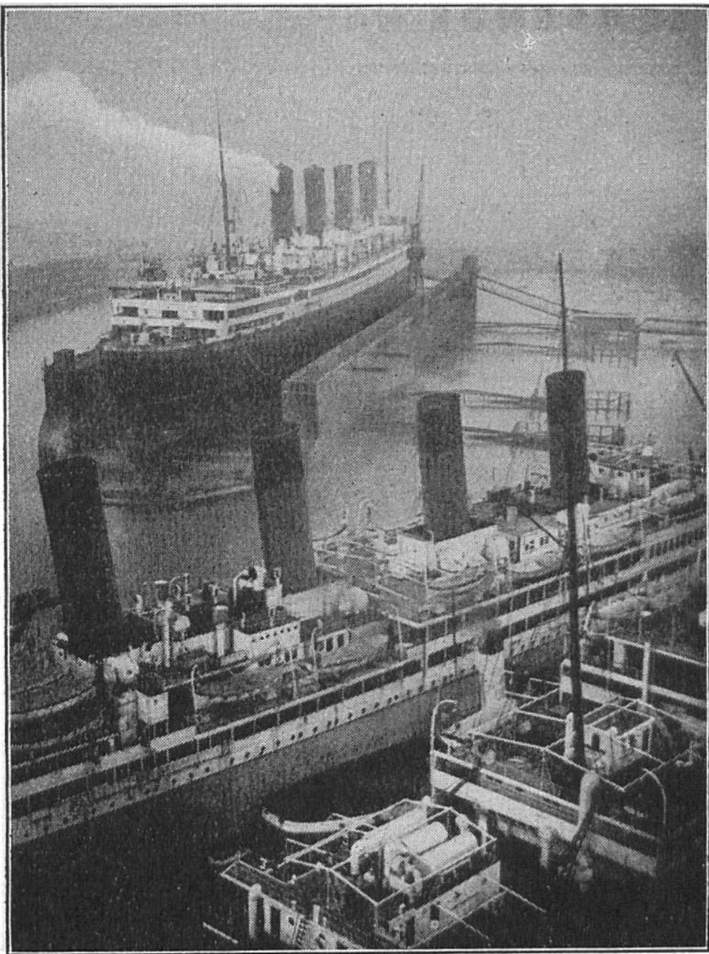
Schiffe im Hafen. Vorn ein Dampfer, der die alljährliche Reinigungskur im Trockendock schon durchgemacht hat. Hinten ein vermittelst des schwimmenden Docks aus dem Wasser gehobenes Schiff. Das Dock war erst tiefer im Wasser gelegen, sodass das Schiff zwischen die beiden hohen Seitenmauern einfahren konnte. Durch Auspumpen des Wassers aus den Kammern des Docks, hob sich das Dock und mit ihm das darin befindliche Schiff, das nun ganz über dem Wasser steht.
