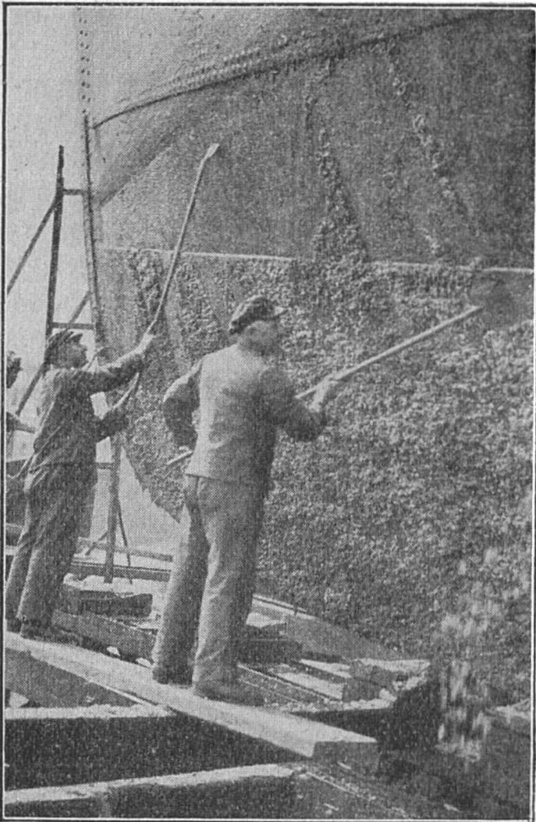
Im Laufe eines Jahres hat sich eine Unmenge kleiner Meertierchen an die unter Wasser befindlichen Schiffswände angesetzt. Die harte, rauhe Schicht muss abgekratzt und der Schiffsrumpf neu gestrichen werden.
