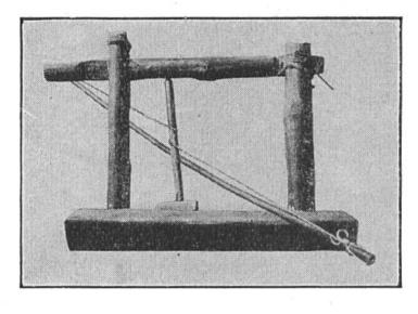
Bohrmaschine aus der neueren Steinzeit. Der Bohrer wird durch das Hin- und Herbewegen des Bogens in Drehung versetzt. Der obere Querbalken dient zur Belastung des Bohrers.
