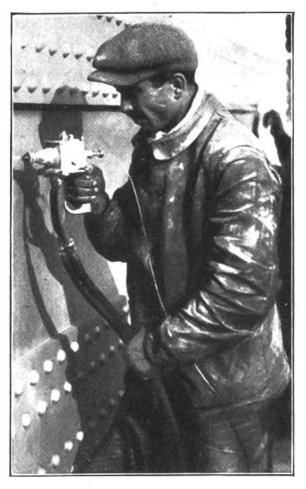
zum Beispiel Blei, Kupfer, Zink oder Bronze auf irgendeinen Gegenstand aufspritzen, so dass dieser von einem soliden Mantel bedeckt wird. Nicht nur Blech und Eisen, sondern auch Zement, Stein, Gips und selbst brennbare Stoffe wie Holz, Papier, Zelluloid oder Tuch können leicht mit irgendeinem Metall überzogen werden. Am meisten wird heute das Schoopsche Verfahren als Rostschutz verwendet. Ein aufgespritzter Zinküberzug
