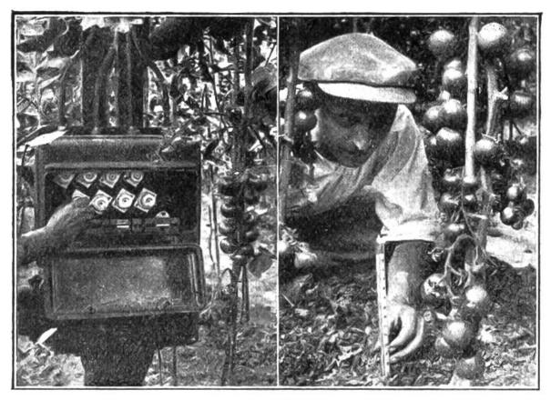
Die Schalttafel für die elektri- Dieser Gärtner steigerte sche Erdheizung. Unterhalb Bodentemperatur seines des Metallkastens verteilen sich zung auf 20° C und erzielte eine
