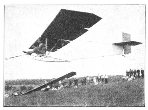
Der Start ist geglückt, das Flugzeug schwebt! Jetzt muss der Pilot aufwärts gerichtete Luftströmungen, die gewissermassen die Kraft des Motors ersetzen, ausnützen, um richtig zu segeln.
