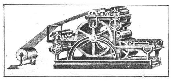
"Bullockpresse", die erste Rotations-Druckmaschine, die von einem sogenannten endlosen Papierband druckte; 1863 vom Amerikaner Bullock erfunden.
