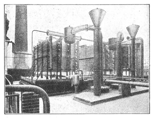
Kühlschlangenanlage auf dem Dach einer Eisfabrik. Eis wird heute so viel gebraucht, dass es in Fabriken hergestellt wird.
