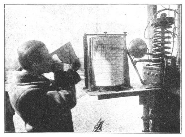
Die Steiggeschwindigkeit, Höhe und das Hinund Hergeschobenwerden des Drachens wird beobachtet. Der auf das Halteseil ausgeübte Druck wird selbsttätig auf einer sich drehenden Walze aufgezeichnet.
