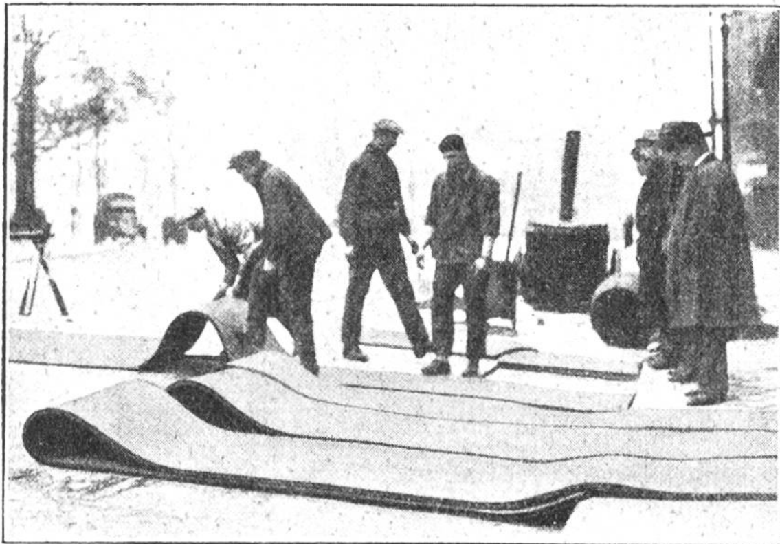
Ein neuer Strassenbelag: statt Asphalt werden Gummit Teppiche in langen Bahnen verlegt und durch Teer miteinander verbunden.
