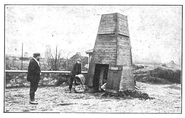
Der Turm, durch den man ins unterirdische Gewölbe hinabsteigt, wo sich die Champignons-Beete befinden. Er ist zugleich eine Lüftungsvorrichtung.
