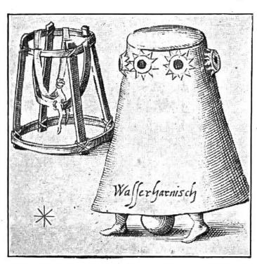
von Tauchervorrichtungen. Ihm schwebte vor, dass der Taucher einen Vorrat von Luft zur Atmung in einer geheimnisvoll hergestellten Weste unter Wasser mitnehmen
