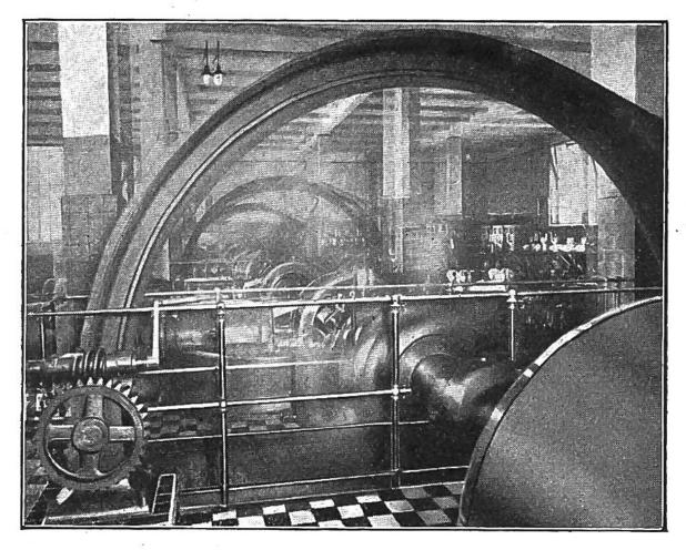
Maschinen in vollem Arbeitsgang. Es sind dampfbetriebene Kompressionsmaschinen, welche Ammoniak unter Druck setzen, so dass es sich als Gas verflüchtigt. Bei diesem Vorgang stellt sich grosse Kälte ein, die Wasser in Kästen zum Gefrieren bringt.
