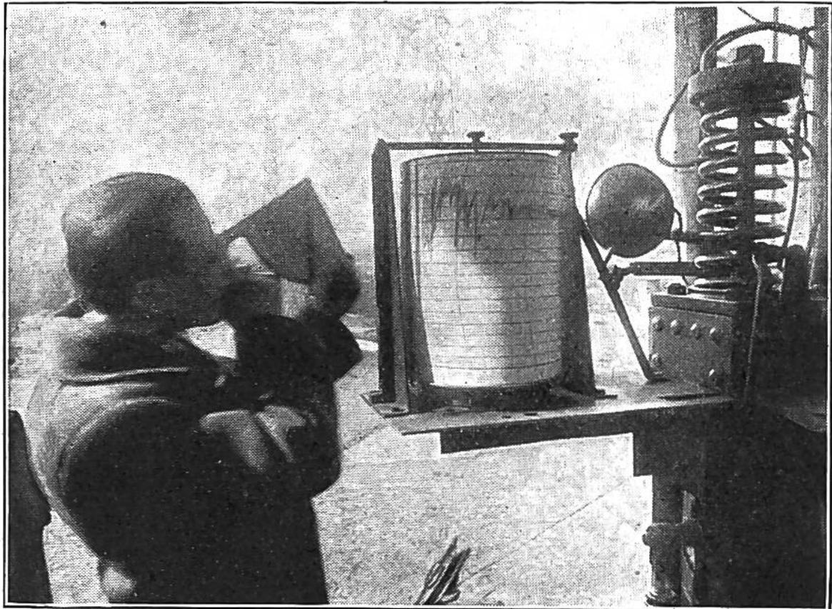
Die Steiggeschwindigkeit, Höhe und das Hin- und Hergeschenkenwerden des Drachens wird beobachtet. Der auf das Halteseil ausgeübte Druck wird selbsttätig auf einer sich drehenden Walze aufgezeichnet.
