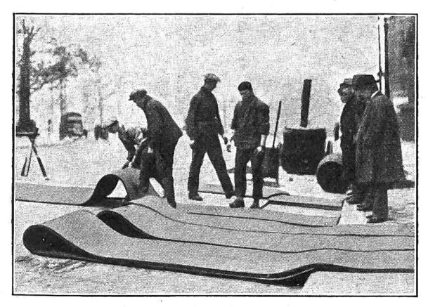
Ein neuer Strassenbelag: statt Asphalt werden Gummiteppiche in langen Bahnen verlegt und durch Teer miteinander verbunden.
