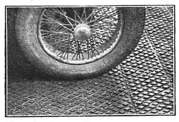
Ein sehr dauerhaftes, aber auch kostspieliges Strassenpflaster sind Eisenplatten, die auf einer Betonschicht ruhen. Dieses Material hat ausserdem die angenehme Eigenschaft, in hohem Masse die Erschütterungen abzufangen. In allen Grosstädten leiden ja die Gebäulichkeiten sehr unter der ständigen Erschütterung, die der Verkehr verursacht. Da-
