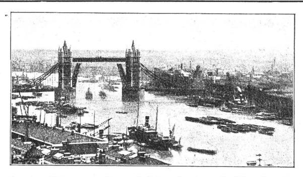
An der Themse: Tower-Brücke, eine doppelte Hängebrücke, deren mittlerer Teil unten aufgeklappt werden kann (wie das Bild zeigt), um grossen Schiffen die Durchfahrt zu gewähren.
