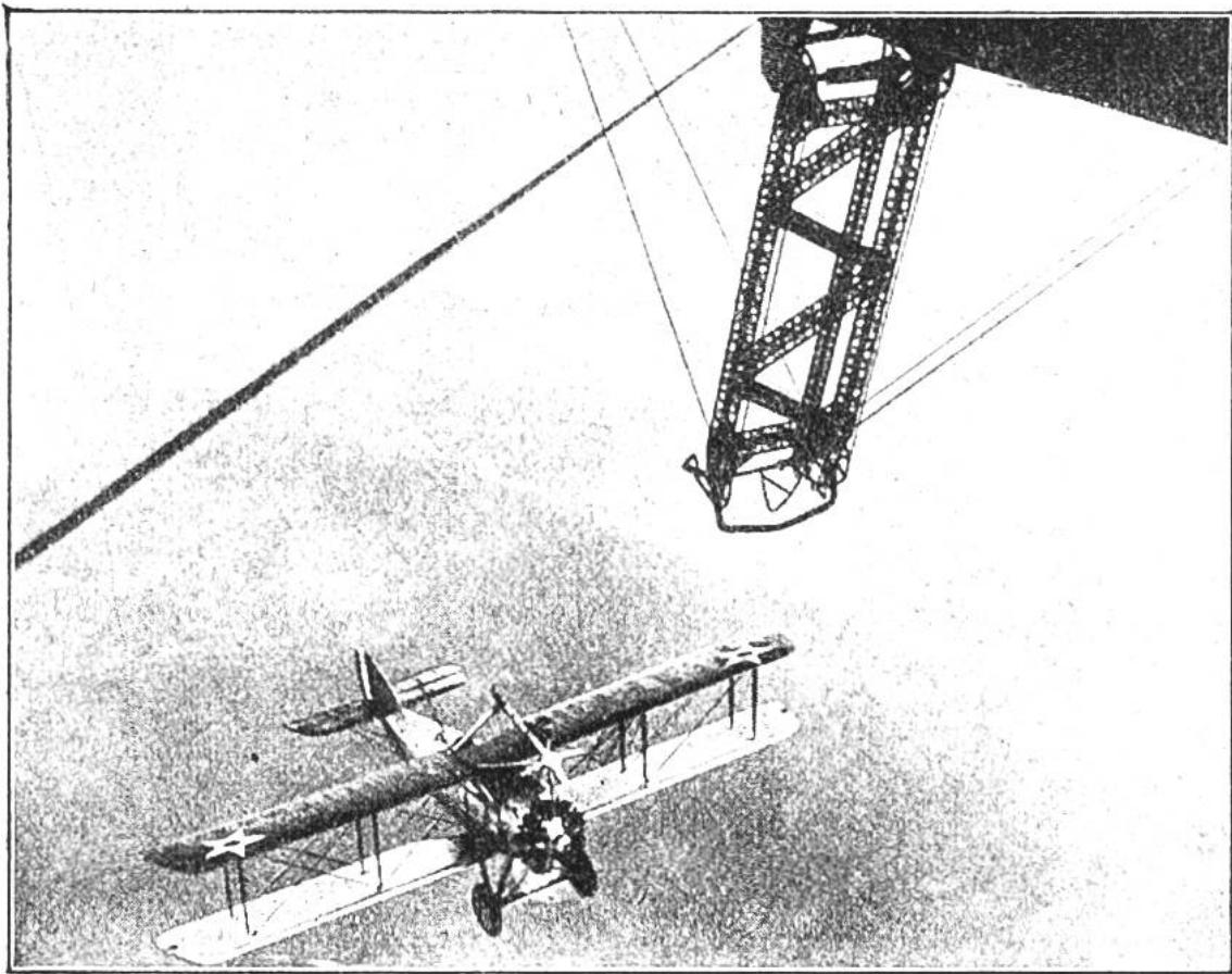
Luftschiff und Flugzeug haben sich auf gleich schnelle Fahrt eingestellt. Sie scheinen gegeneinander stille zu stehen. Das Luftschiff hat den „Landungssteg“ herabgelassen, der zu unterst eine Querstange trägt. Das Flugzeug versucht während der Fahrt mit einem oben angebrachten Haken sich an der Querstange einzuhängen.
