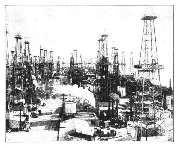
Ölfeld mit Bohrtürmen in einem Vorort von Los Angeles in Kalifornien, wo oft noch im Meere draussen Bohrtürme stehen; es erspart dies die weiten Rohrleitungen zur Verfrachtung des Petrols. Die Mächtigkeit der Türme wird ersichtlich im Vergleich mit den Autos links unten auf dem Bilde.
