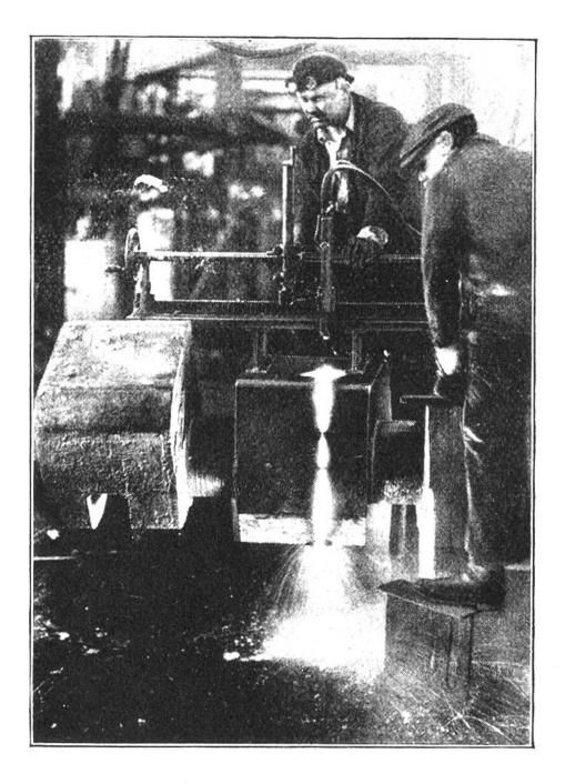
Der Sauerstoffbrenner durchschneidet, vermöge seiner schmelzenden Hitze, ein Stück Gusstahl von 0,5 cm Dicke. So geschieht, wie auf dem Bild, das Zuschneiden einer Kurbelwelle viel rascher als auf der Drehbank.
