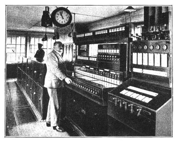
Das "Gehirn", von dem aus der Sicherungsdienst im Eisenbahnverkehr gelenkt wird: Das Stellwerk bei der Bahnhofeinfahrt, von dem aus alle Weichen gestellt und die Signale bedient werden.
