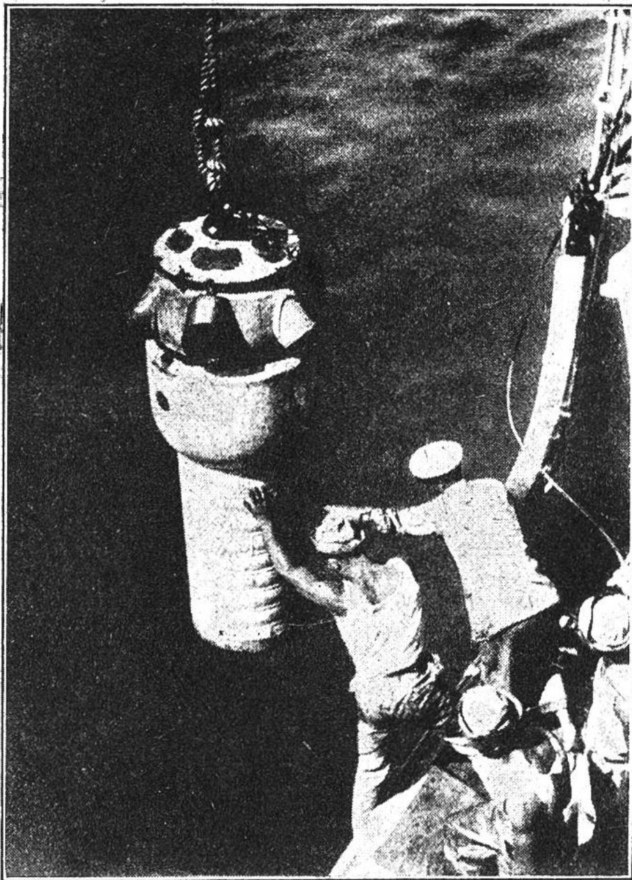
Ein Taucher wird ins Meer hinabgelassen. — Einem italienischen Ingenieur ist es gelungen, einen Tiefseetaucher-Anzug zu konstruieren, mit dem 300 m Tiefe erreicht werden kann, 100 m mehr als mit den bisher gebrauchten Anzügen. Ein moderner Tauchanzug enthält Flaschen mit Pressluft und Sauerstoff, Tanks für Wasserballast, ist elektrisch beleuchtet, und mit Scheinwerfern, Telephon und Morsetelegraph ausgestattet.
