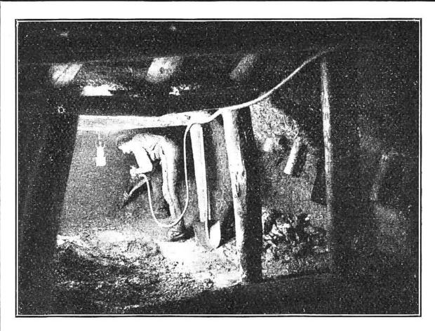
Eisenerzgewinnung mit der Bohrmaschine im Bergwerk der von Rollschen Eisenwerke im Berner Jura.
