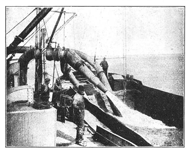
Pumpanlage bei der Trockenlegung der Zuidersee. Das zu erobernde Gebiet wird mit Dämmen eingefasst und dann von Wasser frei gepumpt.
