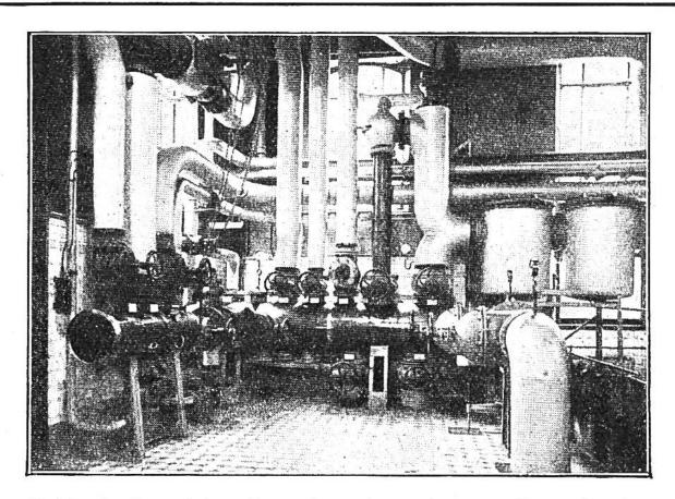
Blick in die Zentrale eines Fernheizwerkes. Hier wird das auf 120°C erhitzte Wasser in grosse Rohre verteilt und zu den einzelnen Häusern gepumpt.
