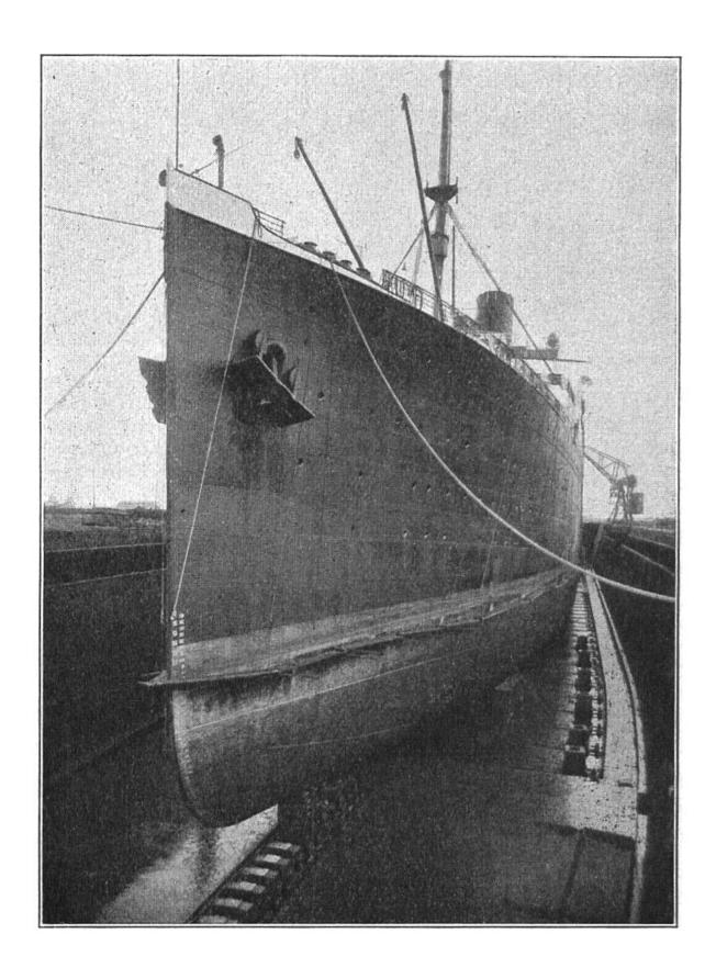
Der "Columbus" in einem Trockendock von Bremerhaven. Trockendocks sind mächtige Becken am Lande, die mit Wasser gefüllt werden können. Hier werden Schiffe gebaut und repariert. Der Kiel des Schiffes ruht auf einer Reihe Holzklötze, dem Kielstapel.
