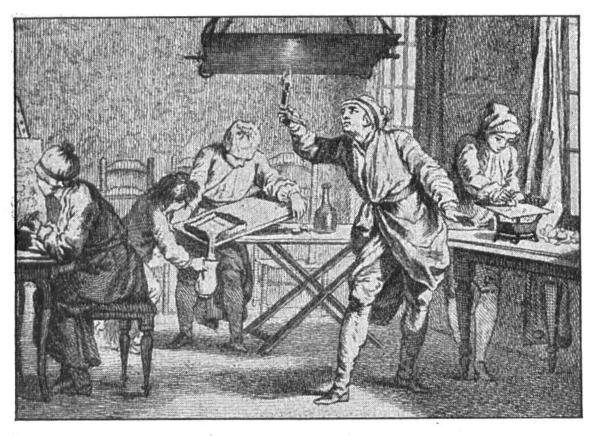
Die Kupferstecher (2). Die Harzschicht auf der Platte wird mit dem Russ einer Kerze geschwärzt. Der Zeichner ritzt jetzt die Zeichnung mit einem Metallstift auf die Platte. Die Striche dringen durch die Harzschicht auf das Kupfer. Eine jetzt über die Platte gegossene Säure ätzt die ganze Zeichnung in die Platte ein. — Ein Arbeiter giesst die Säure ab (Bildmitte), ein anderer (rechts) entfernt das Harz völlig von der Platte.
