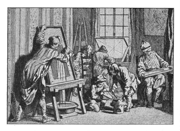
Die Kupferstecher (1). "Stiche" sind Bilder, die auf eine Metallplatte gezeichnet und dann gedruckt werden. Die Platte wird zunächst mit Hülfe von Sandstein und Wasser poliert (Arbeiter links), dann mit einer dünnen Harzschicht überzogen. Die Lehrbuben (Mitte) erwärmen das Harz.
