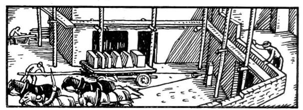
Bei Anwendung einer festen Rolle ist genau die gleiche Kraft nötig, um den Wagen vorwärts zu bewegen: vier Pferde. Der Vorteil besteht einzig darin, dass die Zugrichtung geändert ist.
