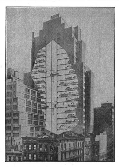
Schematische Darstellung der neu eröffneten 24 Stockwerke hohen Garage für Automobile in New York.
