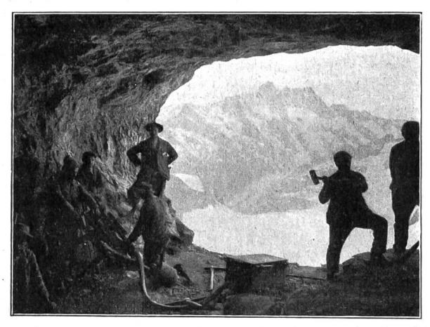
Tunnelbau an der Jungfraubahn. Rechts: die alte Bohrweise mit Meißel und Zuschlaghammer; links: moderne Bohrmaschine mit Preßluft.
