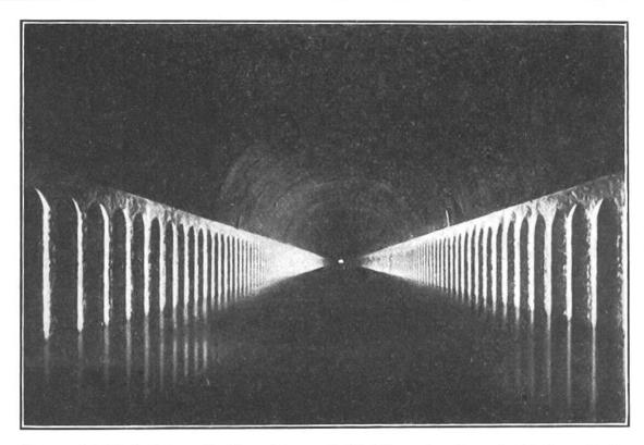
Rove-Schiffahrtskanal. Der Tunnel ist 22 m breit und 15,5 m hoch. Das Wasser ist 4 m tief. Beidseitig oberhalb der Bogen führen Wege von 2 m Breite. Die Ausmauerung des Tunnels bedeutet bei der weiten Spannung des Bogens ein technisches Meisterwerk.
