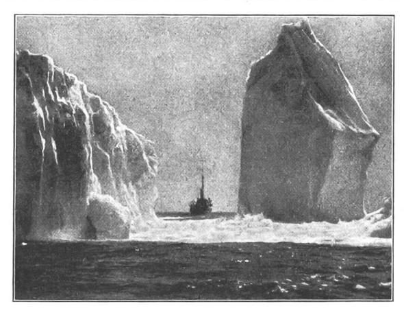
Sprengung eines Eisberges vermittelst einer Mine, die am Berge 10 Meter unter Wasser angebracht wurde.
