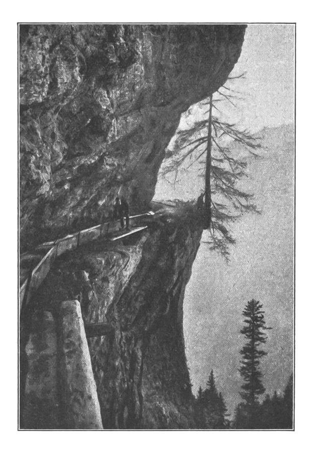
hoch über dem Abgrund. Wasserleitung bei Montana im Wallis. Jede größere Leitung steht unter der Aufsicht eines stänsdigen Wächters mit fester Bezahlung. Lang und beschwerlich sind die täglichen Gänge des hüters, gefährlich die Ausbesserungsarbeiten.
