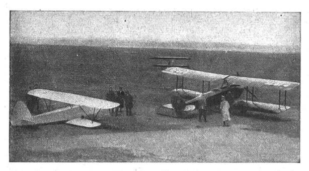
Ein neuer Dersuch. Ein Motorflugzeug nimmt ein motorloses Flugzeug ins Schlepptau. Die Sahrt ist ohne Störung verlausen, doch erscheint es zweiselhaft, daß der Schleppsahrt in den Cüsten je eine ähnliche Bedeutung zukommen wird wie auf der Eisenbahn und auf den Wasserwegen.
