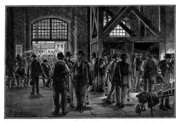
In einem modernen Kohlenbergwerk, Einfahrt zur Schicht. Rechts hinten betreten die Arbeiter den Sörderkorb, eine Art Aufzug, der die Bergleute nach den Abbaustellen und von dort wieder zurückringt. Die Grubenlampen sind mit feinem Drahtgestecht umgeben, das die Entzündung von Grubengasen verhindert.
