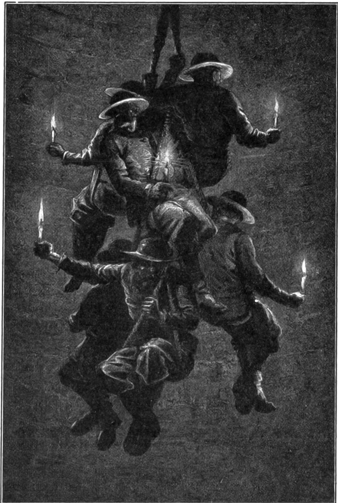
Altes Bild: Einfahrt in ein Salzbergwerk. Die Arbeiter sitzen in Schleifen, die am Förderseile angebracht sind.
