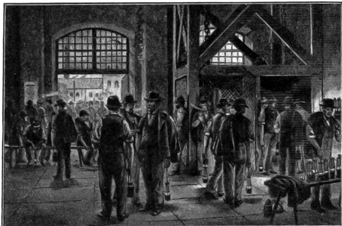
In einem modernen Kohlenbergwerk, Einfahrt zur Schicht. Rechts hinten betreten die Arbeiter den Förderkorb, eine Art Aufzug, der die Bergleute nach den Abbaumöglichkeiten und von dort wieder zurückbringt. Die Grubenlampen sind mit feinem Drahtgeflecht umgeben, das die Entzündung von Grubengasen verhindert.
