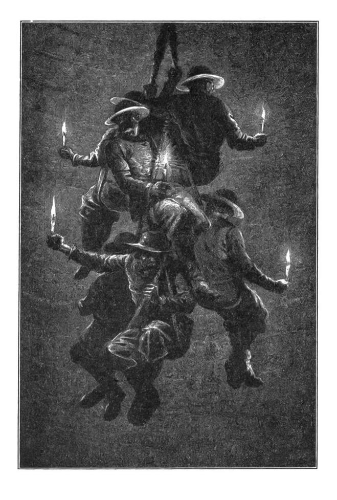
Altes Bild: Einfahrt in ein Salzbergwerk. Die Arbeiter sitzen in Schleifen, die am Sörderseile angebracht sind.
