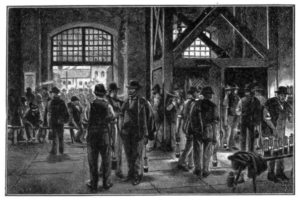
In einem modernen Kohlenbergwerk, Einfahrt zur Schicht. Rechts hinten betreten die Arbeiter den Sörderkorb, eine Art Aufzug, der die Bergleute nach den Abbaustellen und von dort wieder zurückbringt. Die Grubenlampen sind mit feinem Drahtgestecht umgeben, das die Entzündung von Grubengasen verhindert.
