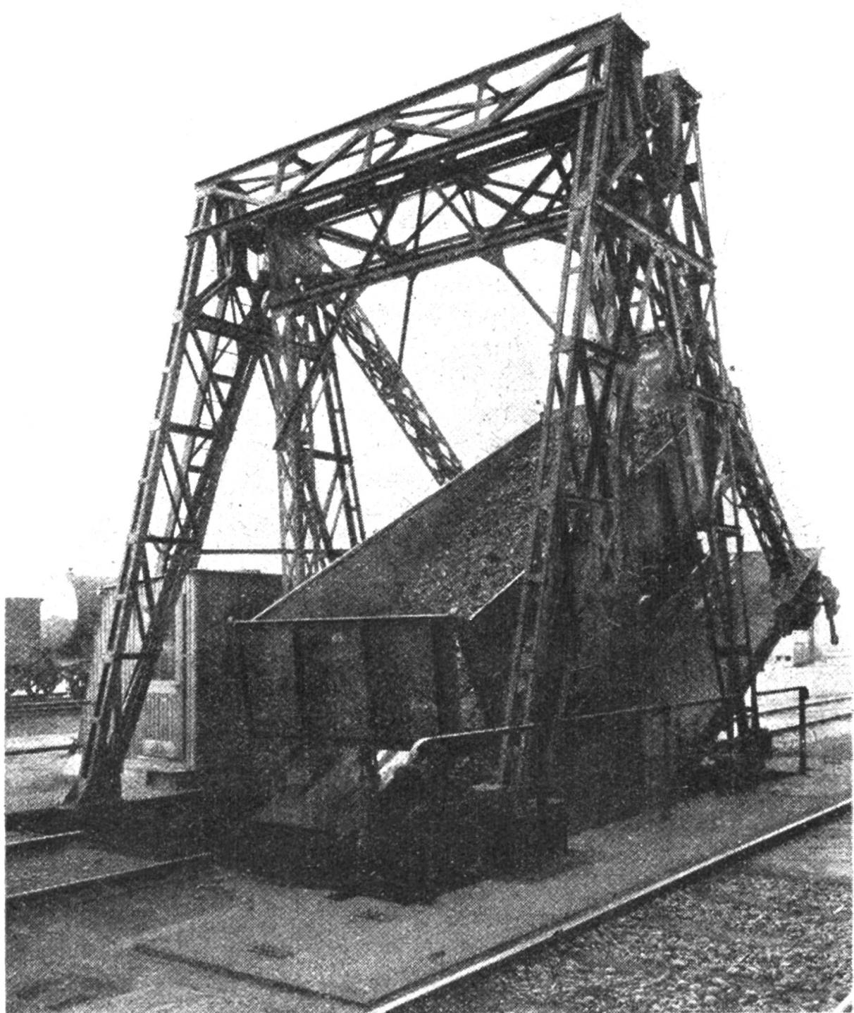
Der Wagentipper, eine Vorrichtung, welche das zeitraubende Ausladen mit Schaufeln überflüssig macht. Solche Apparate sind im Gebrauch bei Gasfabriken, zum Entleeren der Kohlenwagen.
