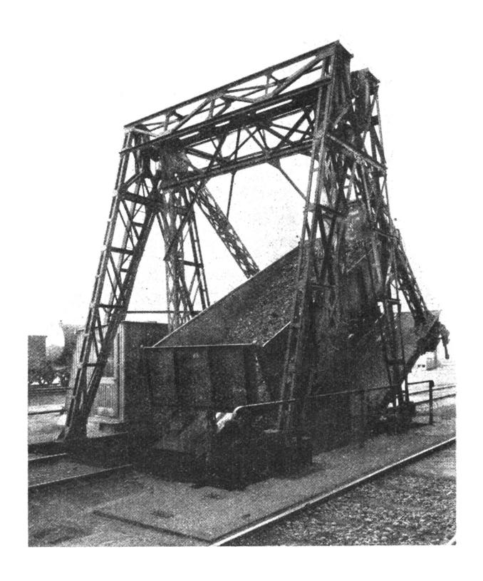
Der Wagenkipper, eine Vorrichtung, welche das zeitraubende Auszladen mit Schaufeln überflüssig macht. Solche Apparate sind im Gebrauch bei Gasfabriken, zum Entleeren der Kohlenwagen.
