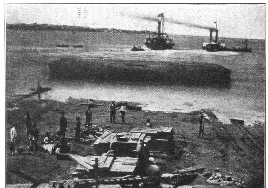
Bereit zur Seesteise: Die "Nadel der Cleopatra" ruht im massiven Holzzylinder mit einges bauten, wasserdichsten Luftkammern, die sie in schwimsmendem Gleichgeswicht erhalten. Die intelligente Derpakstungsart wurdevon einem Schiffsbausmeister eigens zum "Dersand" der Riessensnadel erdacht.
