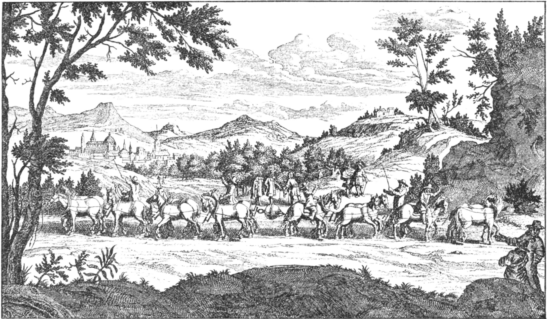
Ein berühmtes Experiment zum Nachweis des Luftdruckes: Otto von Guericke führt anno 1654 Mitgliedern des Reichstags zu Regensburg seine „Magdeburger Halbkugeln“ vor. 16–24 Pferde vermochten die dicht aufeinander gepaßten, luftleeren Halbkugeln nicht auseinander zu reißen. Als Luft einströmte, fielen sie auseinander.
