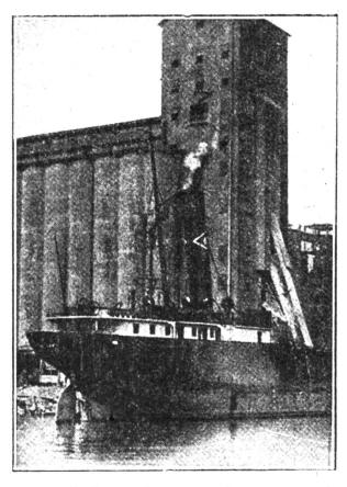
Getreidedampfer vor einem ameristanischen Silo; vermittelst Saugsapparaten wird das Korn direkt vom Schiffsinnern in die geräusmigen Vorratskammern eingesogen.
