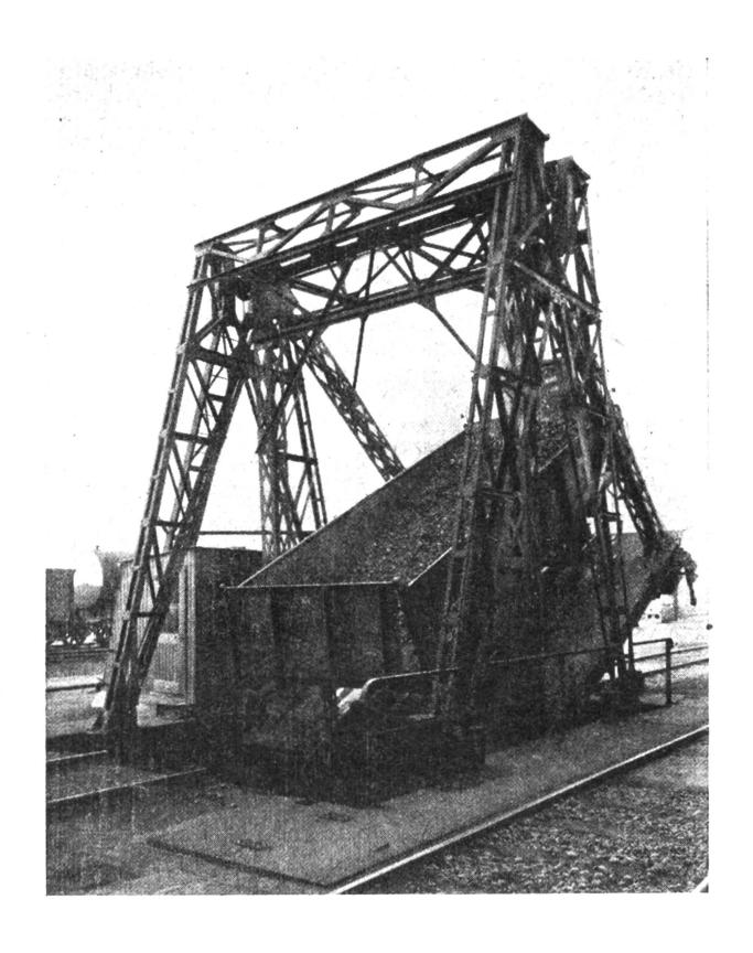
Der Wagentipper, eine Vorrichtung, welche das zeitraubende Aussladen mit Schaufeln überflüssig macht. Solche Apparate sind im Gebrauch bei Gasfabriken, zum Entleeren der Kohlenwagen.
