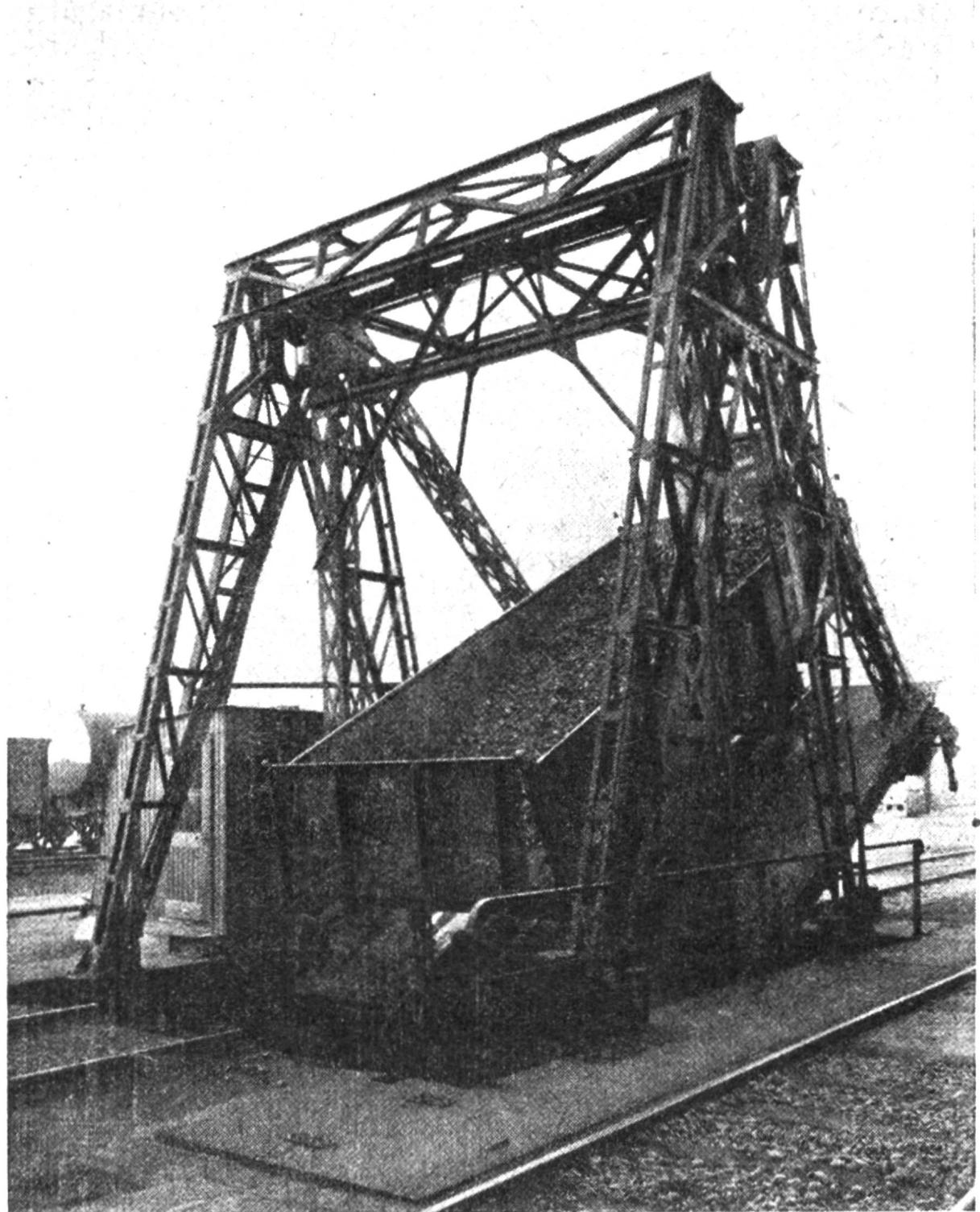
Der Wagenkipper, eine Vorrichtung, welche das zeitraubende Ausladen mit Schaufeln überflüssig macht. Solche Apparate sind im Gebrauch bei Gasfabriken, zum Entleeren der Kohlenwagen.
