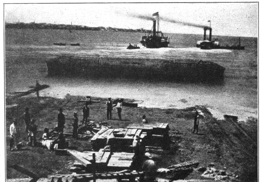
Bereit zur Seesreise: Die "Nadel der Cleopatra" ruht im massiven Holzzylinder mit eingebauten, wasserdichten Luftkammern, die sie in schwimsmendem Gleichgewicht erhalten. Die intelligente Derpakstungsart wurdevon einem Schiffsbausmeister eigens zum "Dersand" der Riessen-Nadel erdacht.
