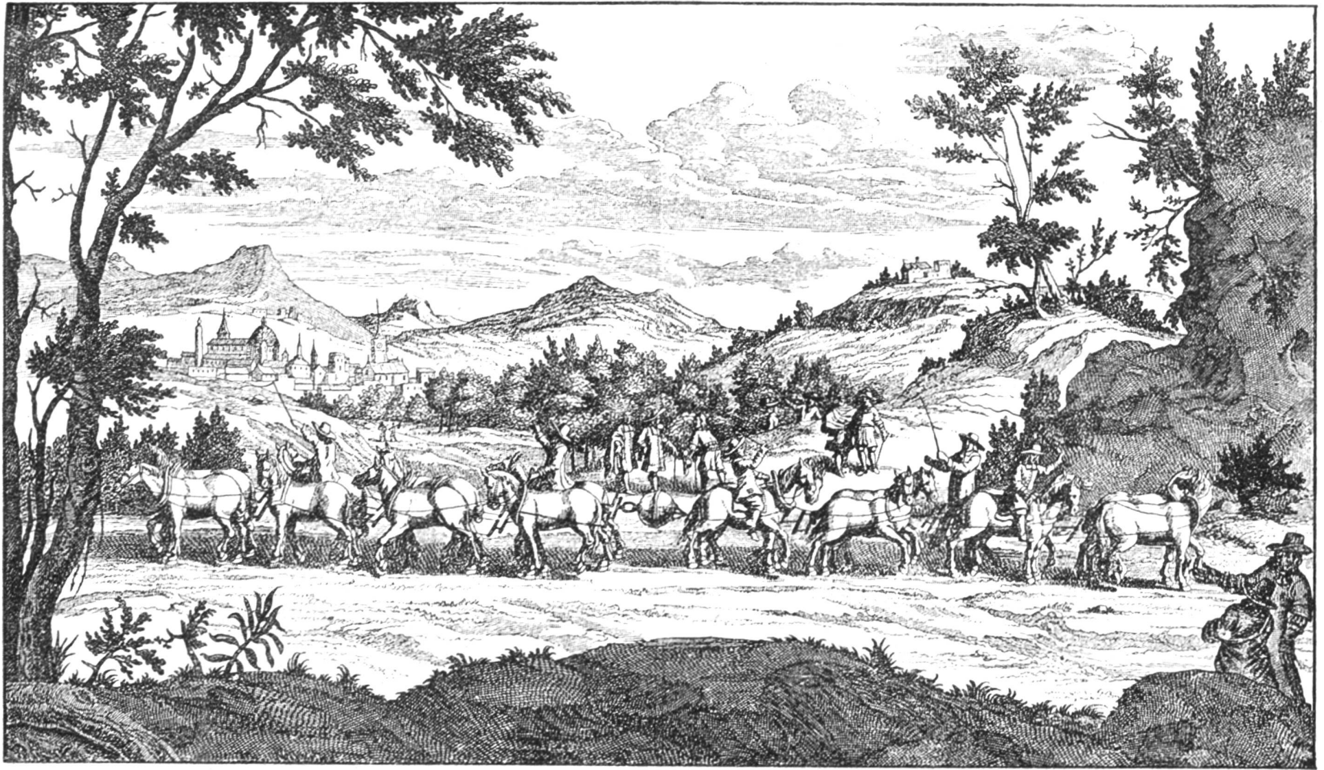
Ein berühmtes Experiment zum Nachweis des Luftdrudes: Otto von Guericke führt anno 1654 Mitgliedern des Reichstags zu Regensburg seine „Magdeburger Halbkugeln“ vor. 16–24 Pferde vermochten die dicht aufeinander gepaßten, luftleeren Halbkugeln nicht auseinander zu reißen. Als Luft einströmte, fielen sie auseinander.
