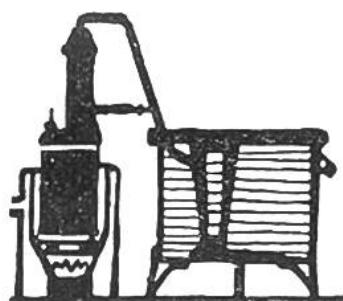
1834. Eismaschine mit Äther vom Engländer Perkins gebaut. Eismaschine durch Verdunstung von Ammoniak 1860 von dem franz. Ingenieur Carré erfunden, eine Erfindung von unberechenbarem Wert für die Nahrungsmittel-Industrie.
